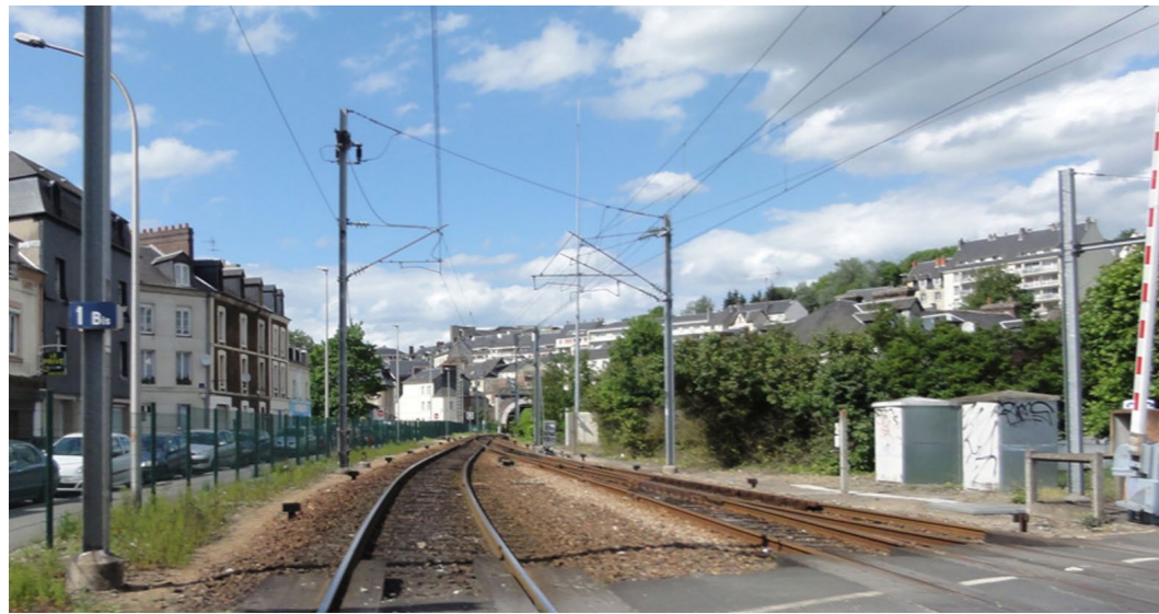
Voies ferrées de la ligne existante avant l'arrivée en gare de Lisieux.
