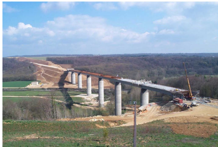
Franchissement de vallée par la LGV Est. Source: EGIS/ Scott Kunitani.
