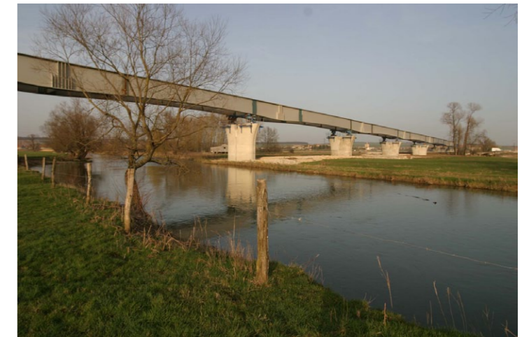
Franchissement de cours d'eau par la LGV Est. Source: EGIS/ Eric Benard.
