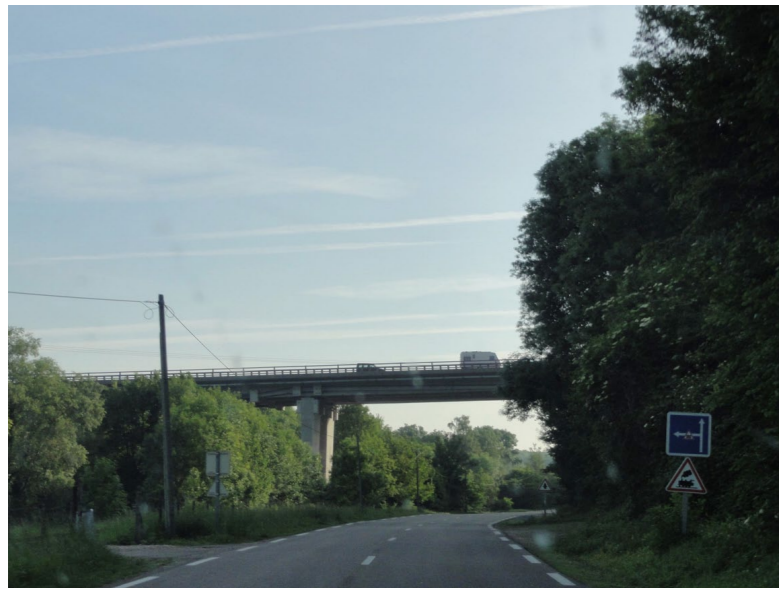
Ouvrage d'art de l'A13 franchissant l'Eure (à gauche) et la route de Saint-Pierre-du-Rauvray. L'A13 arrive sur le coteau de la rive droite de l'Eure.
