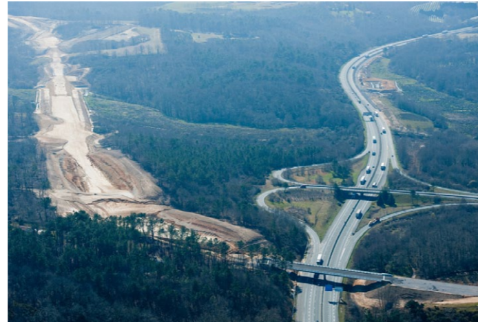
Travaux et traversée de massif boisé. Source: EGIS.
