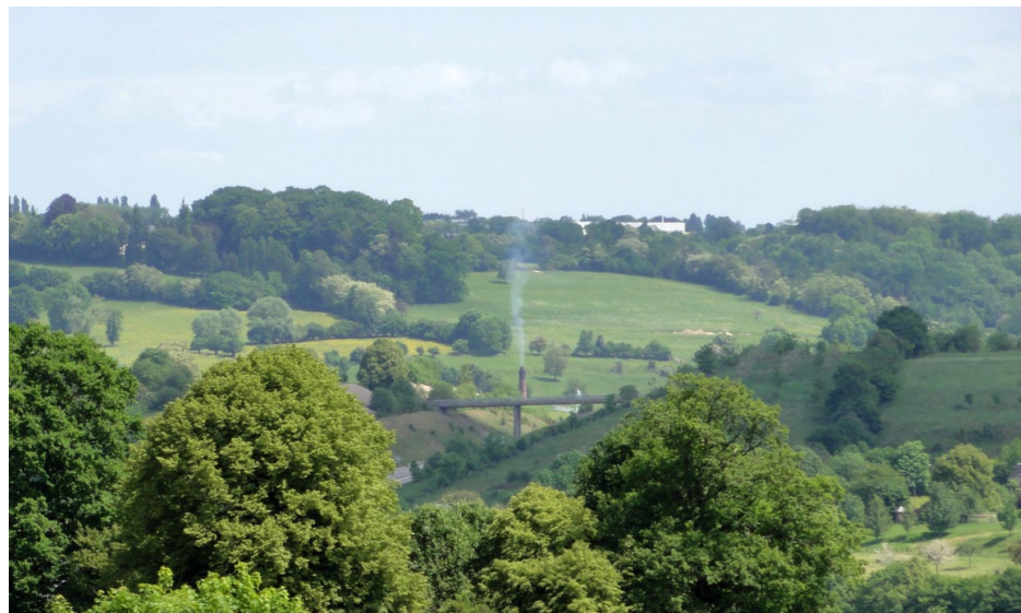
Ouvrage d'art franchissant un des vallons caractéristiques du pays d'Auge à l'ouest de Lisieux.
