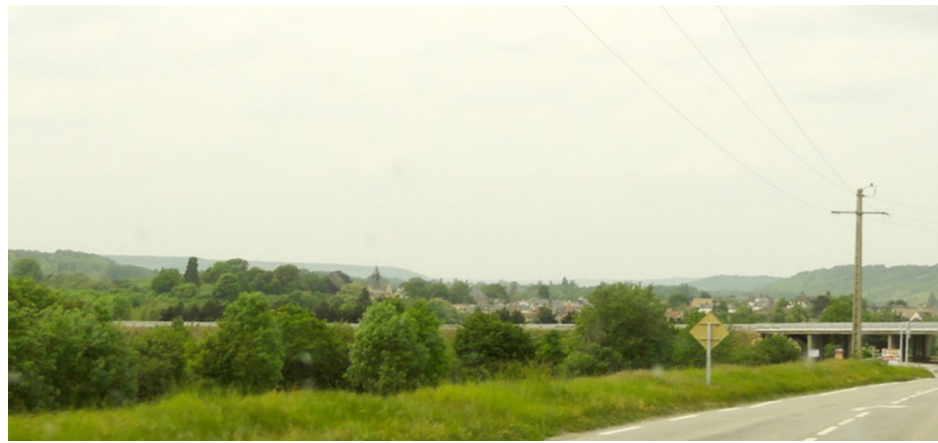
Franchissement de la vallée de l'Eure par l'ex RN 13, au sud de Pacy-sur-Eure.
