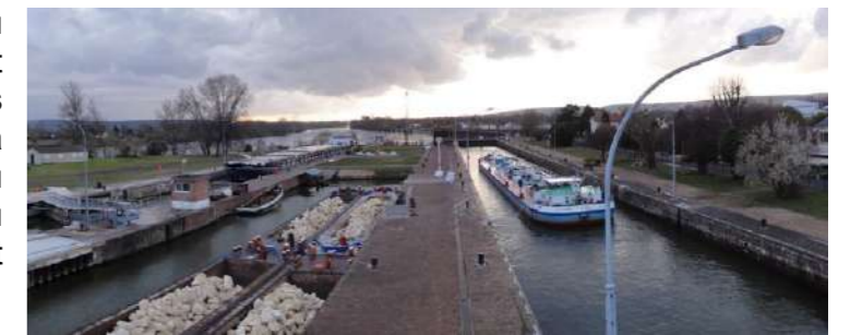
Ecluse de Poses.
