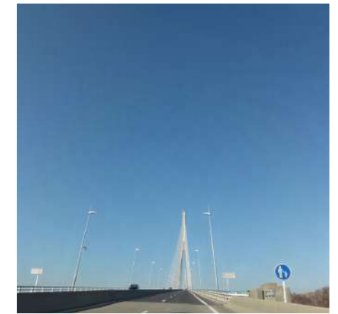
Pont de Normandie.
