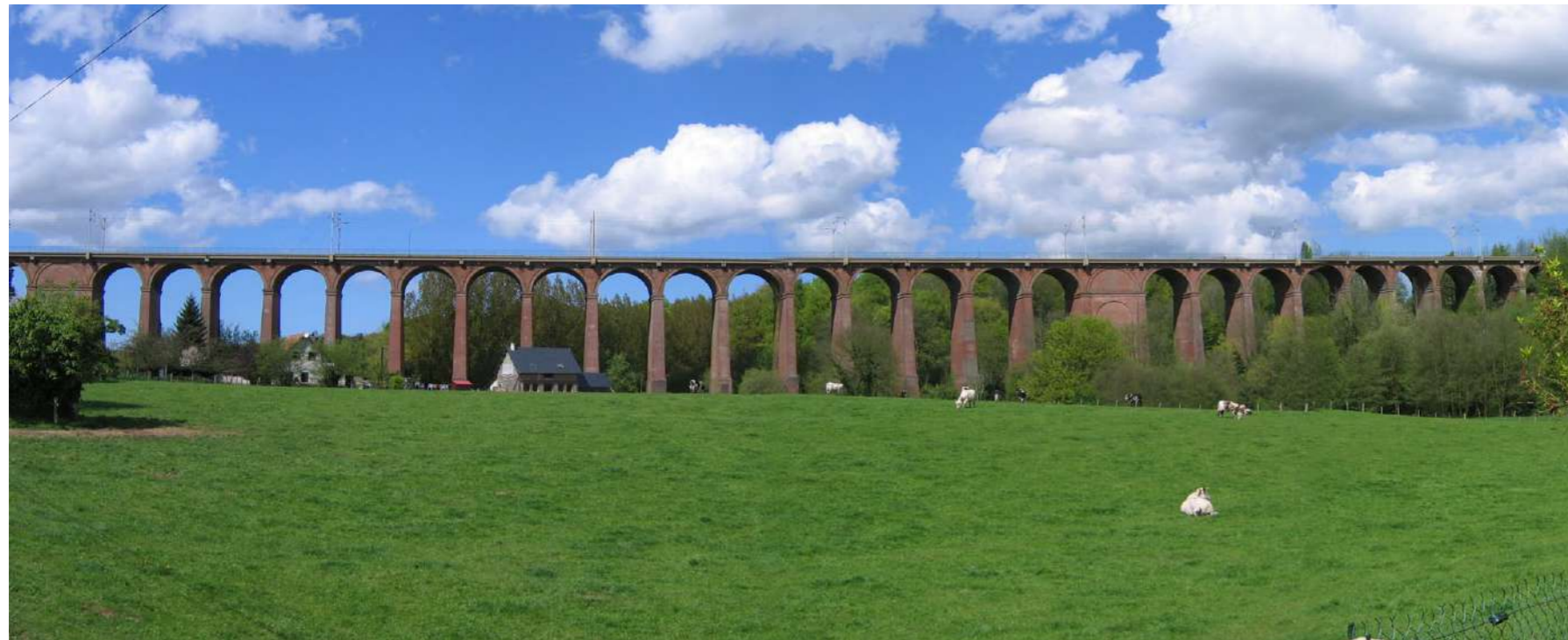
Les Arcades de Mirville, voie ferrée Paris/Le Havre pont construit en 1844 par Newmann en brique rouge, 524 m par 32 m de haut. Source: wikipedia.
