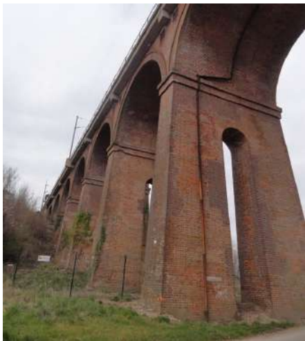
Arcades de la voie ferrée Paris / le Havre à Mirville.
